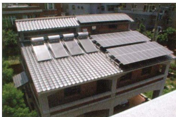
▲圖六 彭小姐家中的太陽光電發電系統及太陽能熱水器
