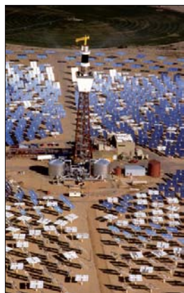
◀▲太陽爐：高塔周圍的面鏡將陽光聚焦於高塔上，產生很高的溫度。
